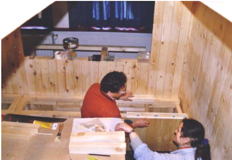
Tijdens de bouw van de kajuit op de zolder
