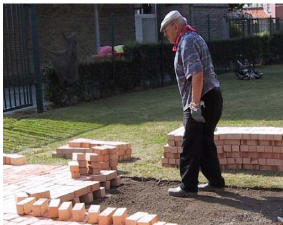
De bouw van de veldoven onder leiding van Adhemar Neyts
