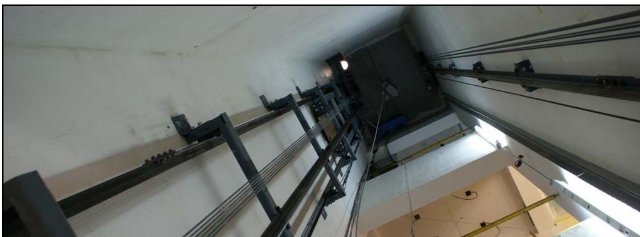
Liftschacht Oud Schoolgebouw
