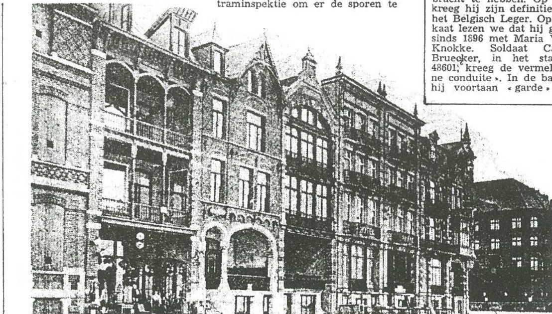
De rij villa's en het Hotel du Phare bij het centrum van de dijk vóór de 1e Wereldoorlog. Al deze gebouwen zijn ondertussen reeds verdwenen.
