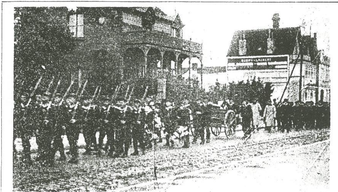
De begrafenis van een Duitse marinier te Knokke. Er wordt opgestapt langs de Lippenslaan ter hoogte waar nu het gebouw van Ebes staat op de plaats der grote villa. Merk ook hoe op de gebouwen franstalige opschriften door de bezetter overschilderd werden.
