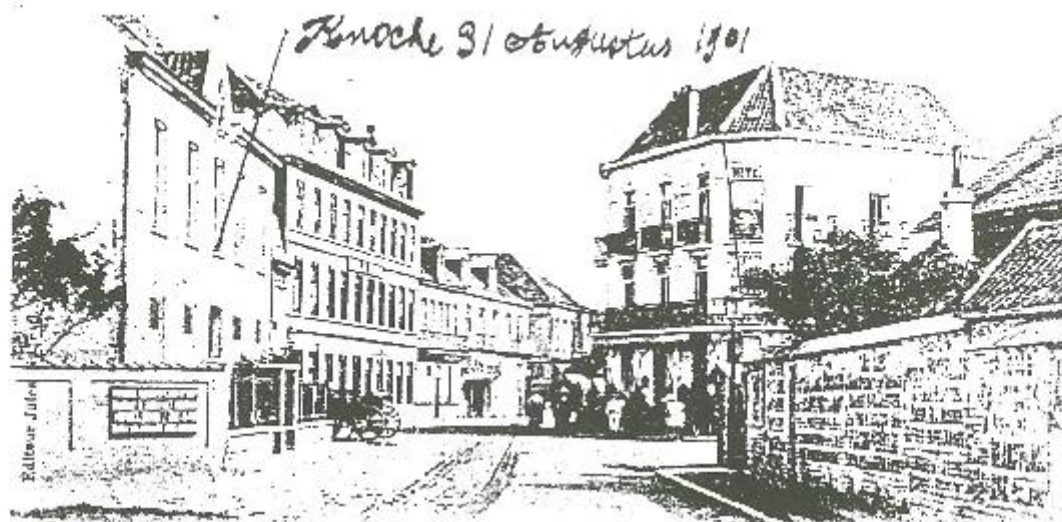
“AU LITTORAL BELGE. KNOCKE. Arrêt du Tram Vicinal.
