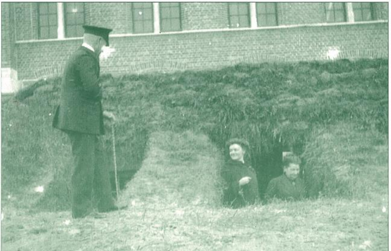
Scherfvrije schuilplaatsen gegraven: achter het stadhuis, voor het burgerpersoneel dat daar werkzaam was.
