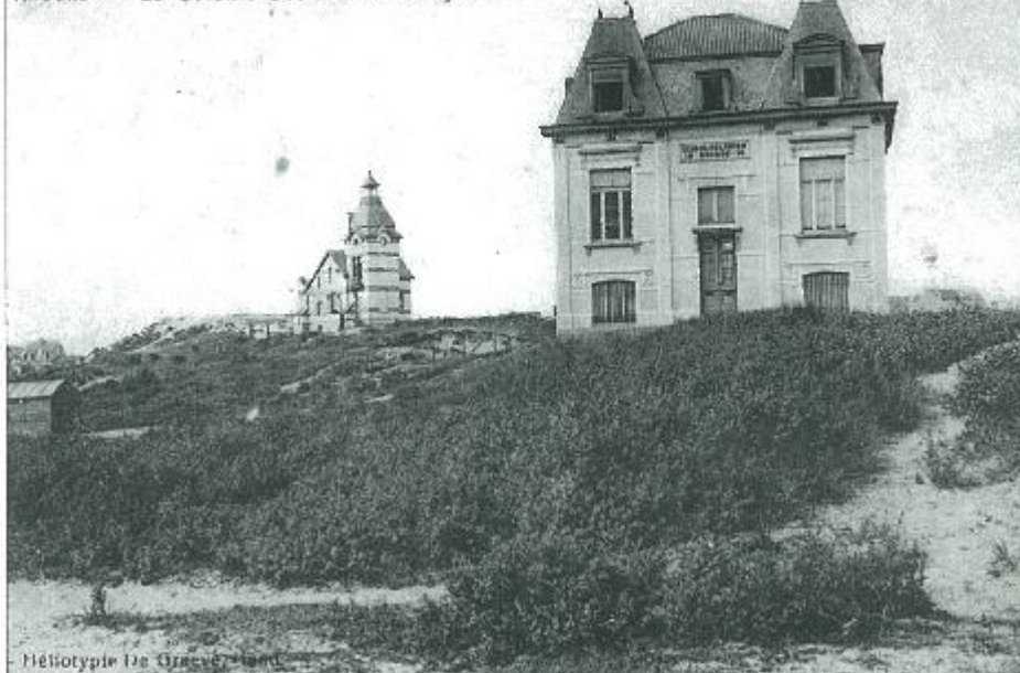
Midden de duinen de schoolkolonie, op de achtergrond "Plettinck huys" en villa La Tremblaise uit 1895 van dokter Alphonse Plettinck uit Brugge. De villa werd in 1935 afgebroken; op die locatie bevindt zich nu de speelplaats van de Vrije Heilig Hart school.
