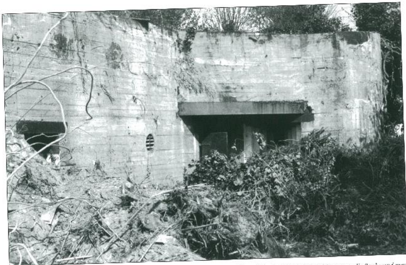
De bunker tijdens de afbraak. Rechts van de rechteringang zien wij de "Scharienstand" gewachtruimte voor een machinegeweer die flankerend vuur kon afgeven naar de twee toegangen van de bunker. In het schietgat stak een pantserplaat.
