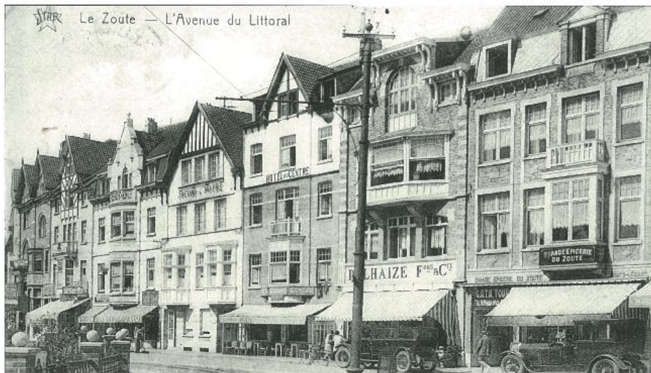
Verblijfplaats van Hardtman Berkeley langs de Kustlaan.
