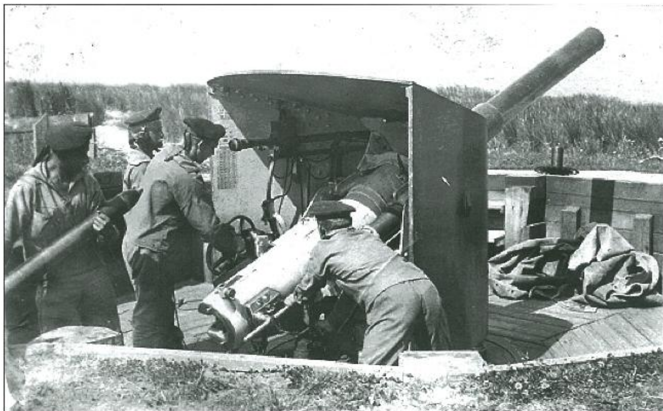
De batterij Bremen was uitgerust met vier 10,5 cm kanonnen, S.K. I./10. Deze stonden op een ijeren onderstel in een betonnen bedding. Rechts van de kanonnen was er een telemeter en later ook een bunker, van waaruit de vuurbeslzen werden gegeven. De munitie werd aangevoerd met een smalspoor van 60 cm (bij ons beter gekend als Décauville). De kanonnen hadden een draaiwiel van 360°.
