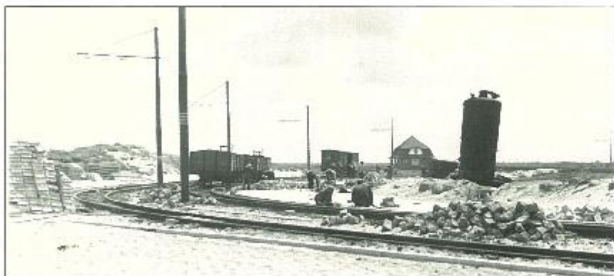
De aanleg van de elektrische tramlijn naar de Oosthoek ter hoogte van de Lobberbek (1928-1929). Op de achtergrond het bronhuize.
