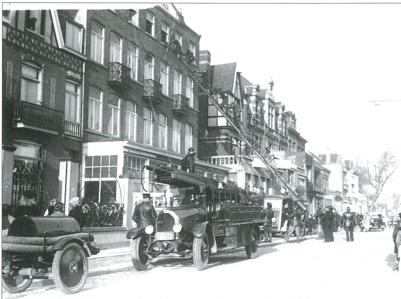
Een brandweeroefening in 1935 bij het hotel 'l'Esperance' tegenover het Verweeplein.
