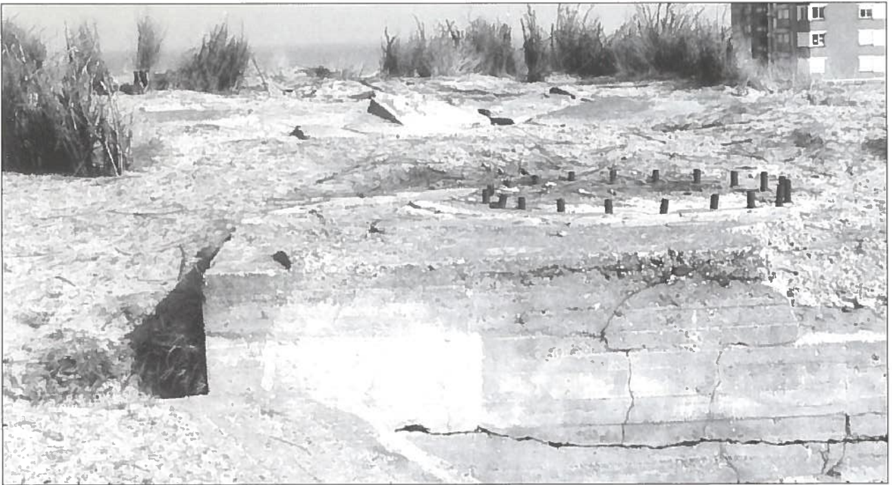
In 1991 lag deze betonnen steunplaat bloot in het Directeur-Generaal Willempark nabij de Anemonenlaan. Het is hoogstwaarschijnlijk onderdeel van een geschutsbedding van de Augusta batterij. Aan de stalen bouten die stevig verankerd waren in het beton werd het onderstel van het 15 cm kanon vast gevezen.
