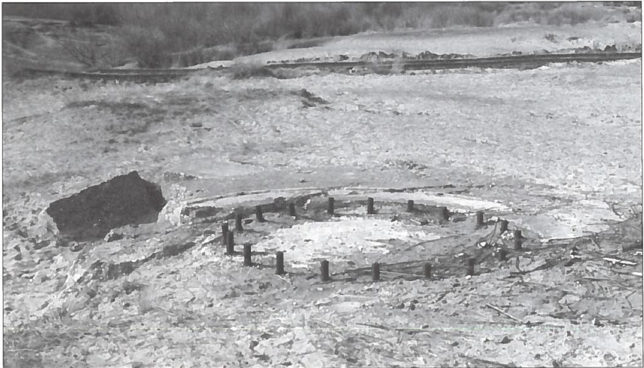
In 1991 lag deze betonnen steunplaat bloot in het Directeur-Generaal Willempark nabij de Anemonenlaan. Het is hoogstwaarschijnlijk onderdeel van een geschutsbedding van de Augusta batterij. Aan de stalen bouten die stevig verankerd waren in het beton werd het onderstel van het 15 cm kanon vast gevezen.
