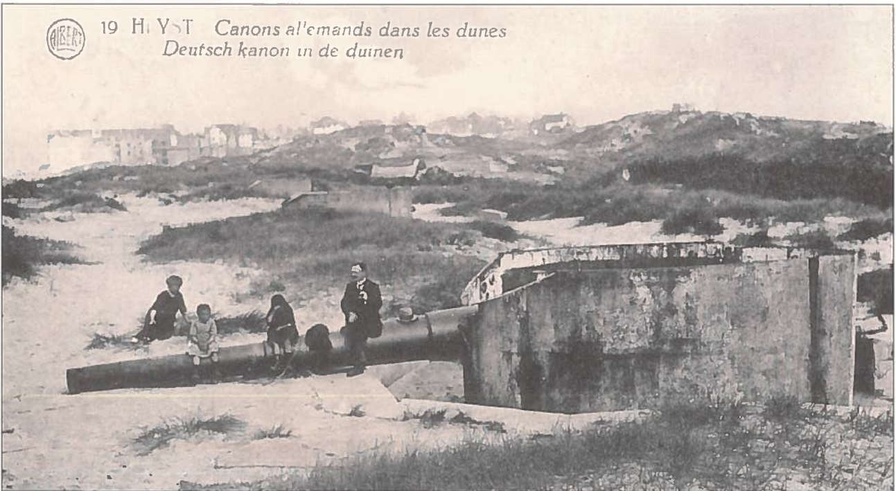
Batterij Freya met één van de 21 cm SK L/40 kanonnen, die een draagwijdte hadden van 22,6 km. De geschutstorens zijn afkomstig van oorlogsschepen van de Freya klasse. Op de foto is te zien dat door een interne ontploffing bij het onklaar maken van het kanon het dak van de geschutstoren werd afgerukt. Bevelhebbers waren Kapitanleutnant der Reserve Menge en Oberleutnant der Reserve Heuer.
