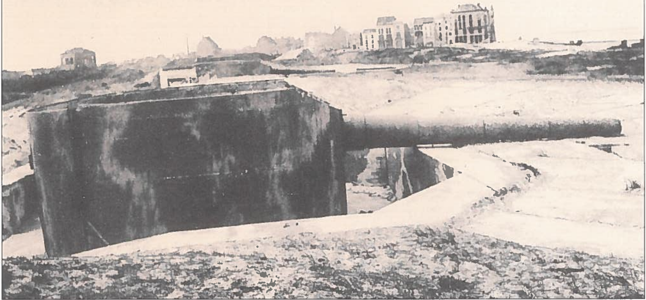
Freya. Op deze prentkaart is duidelijk de achthoekige betonnen bedding voor het kanon zichtbaar.
