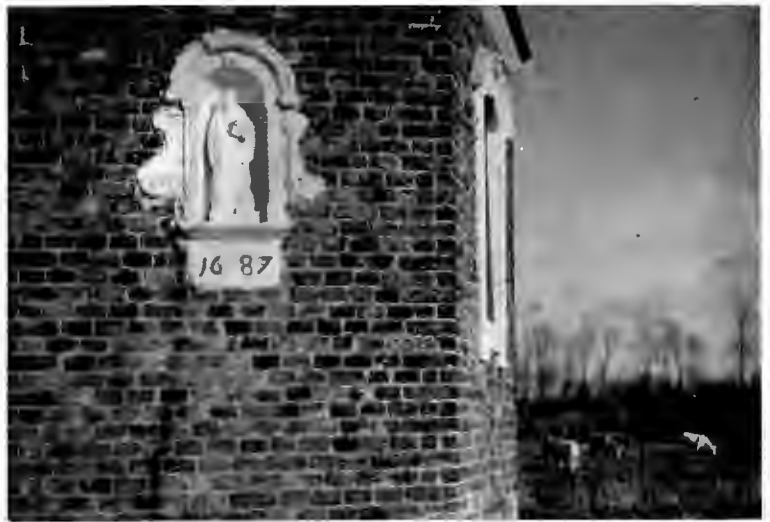
Kapel te Lissewege : Detail van achtergevel met St-Bernardusbeeld en jaartal.
